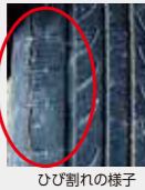
ひび割れの様子
